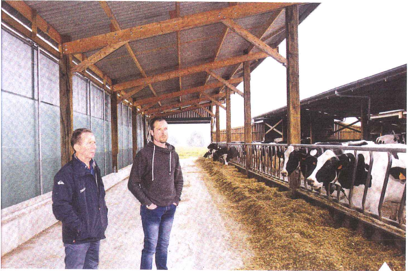
Un filet brise-vent, dont l'ouverture est automatisée par station météo, a été installé en face du couloir d'alimentation.
