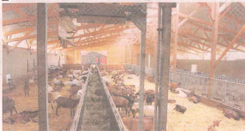
Les quatre rangées de cases de la chèvrerie sont desservies par deux tapis d'alimentation de 50 m de long chacun. A terme, le bâtiment abritera 350 chèvres en production.
