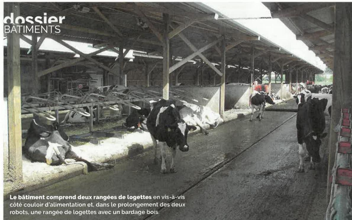
Le bâtiment comprend deux rangées de logettes en vis-à-vis côté couloir d'alimentation et, dans le prolongement des deux robots, une rangée de logettes avec un bardage bois.
