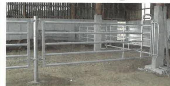
Les poteaux des barrières de la partie modulable du bâtiment sont insérés dans des fourreaux scellés au sol.
