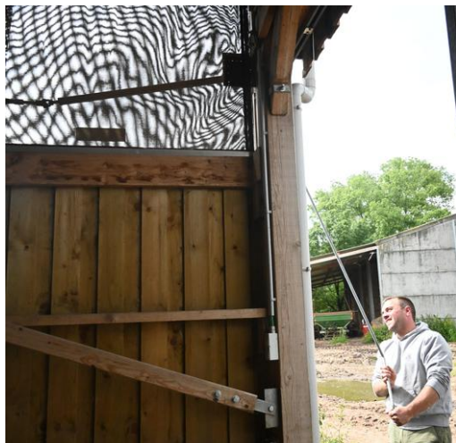
Les rideaux brise-vent sont enroutables. D.T.
